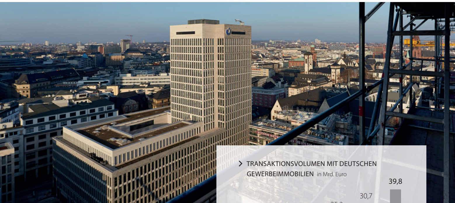
Büro-Hochhaus „MainTor Porta“: an Union Investment Real Estate GmbH verkauft
