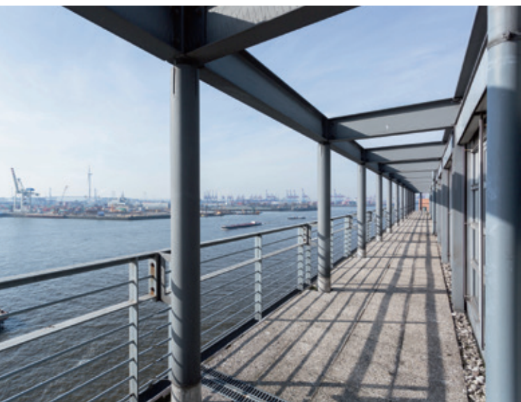
Dachterrasse Elbspeicher Hamburg, ein Objekt des „DIC Office Balance II“
